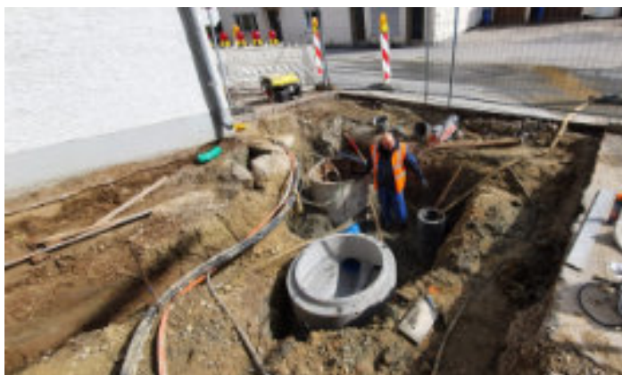
Die Suche nach Erdleitungen im Kollinger Weg führten zur Verzögerung
