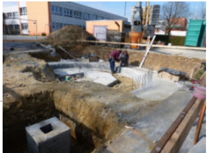
Die Fundamente zum Pavillon sind gegossen
